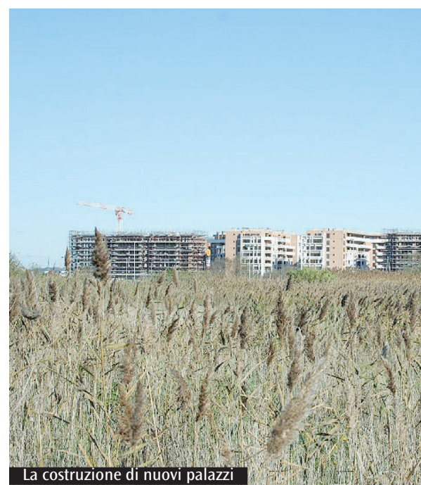
La costruzione di nuovi palazzi
